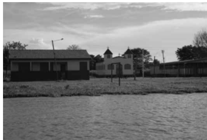
Figura 1 Centro da comunidade Santíssima Trindade - Óbidos - Pará - Brasil
